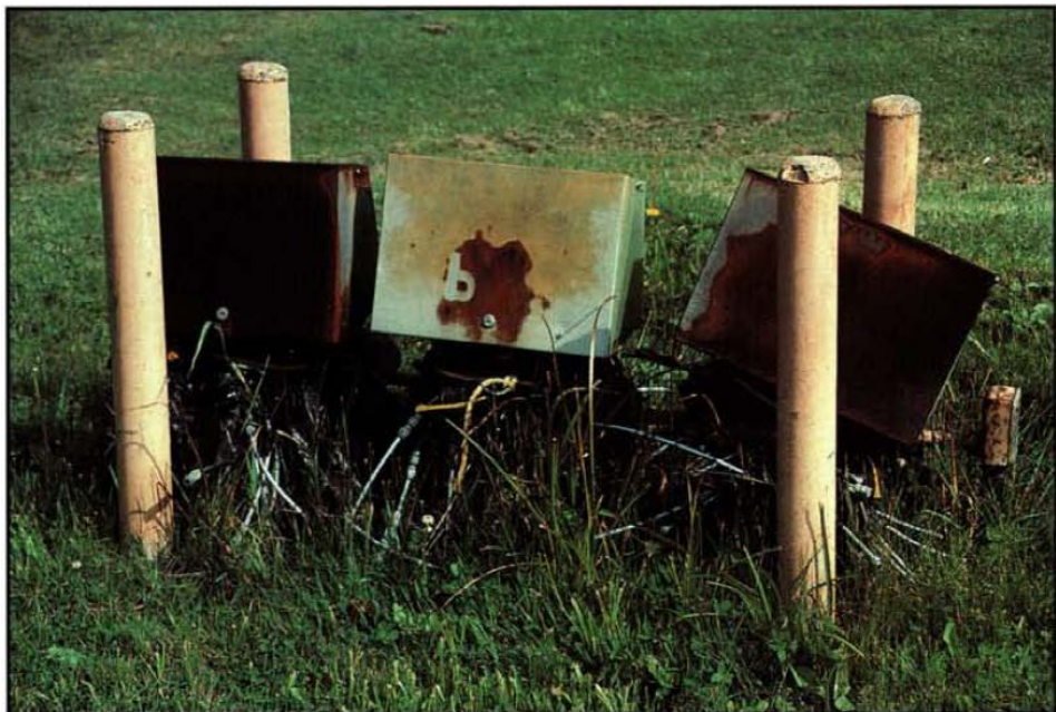
¿Este es un sistema de última generación o en estado de deterioro? La evaluación de su sistema es el primer paso para determinar dónde se deben hacer las mejoras o si el sistema necesita ser actualizado o reemplazado.
