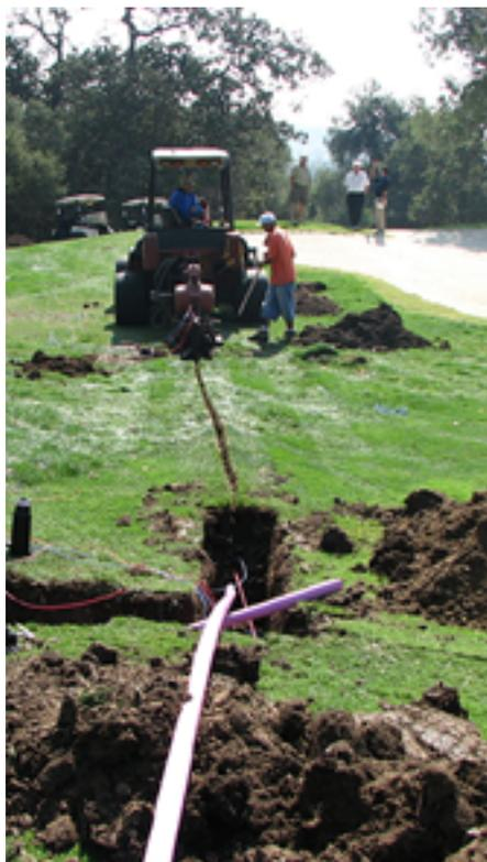
*El reemplazo de la tubería es un gran esfuerzo, pero proporciona la oportunidad ideal para mejorar el diseño hidráulico del sistema, modificar el espaciamiento de los aspersores e incorporar nueva tecnología que puede mejorar la uniformidad del riego.*
