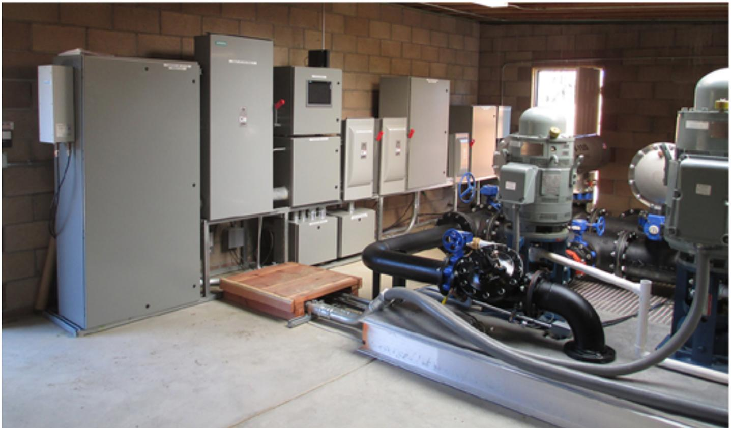
*Los controles y estaciones de bombeo de accionamiento de frecuencia variable son ejemplos de mejores tecnologías disponibles para los campos de golf. Siempre que el sistema de tuberías este bien diseñado, la actualización del sistema de bombeo puede tener un impacto substancial en la uniformidad de riego y en la reducción del consumo de energía.*
