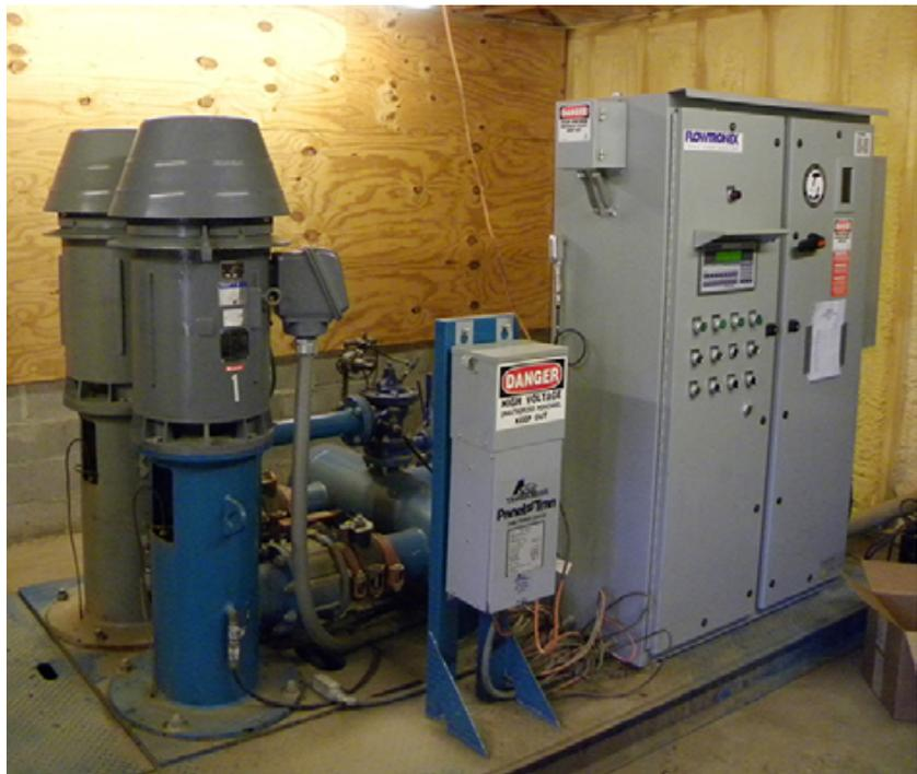
*La estación de bombeo proporciona la energía para empujar el agua a través de tuberías de riego y, finalmente, a través de los aspersores de riego en cada zona del campo de golf.*
