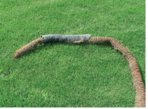
有时,树根可以完全吞 没并损坏排水管道。
