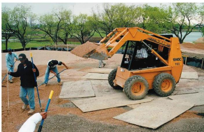
使用重型胶合板来防止重型设备损坏排水管线。
