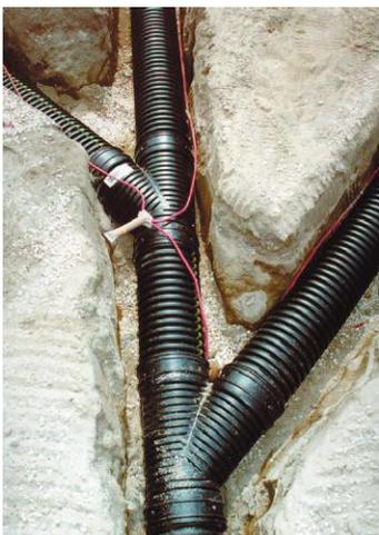
将 # 14 灌溉用线放入每一条沟渠中，今后使用导线跟踪装置就能很容易找到位置
