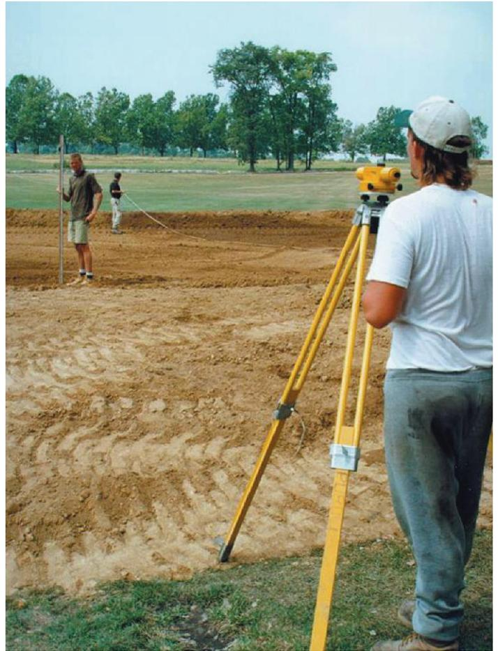
使用勘测仪器测量，以确保排水沟渠到出口点处具有至少 0.5% 的坡度。
