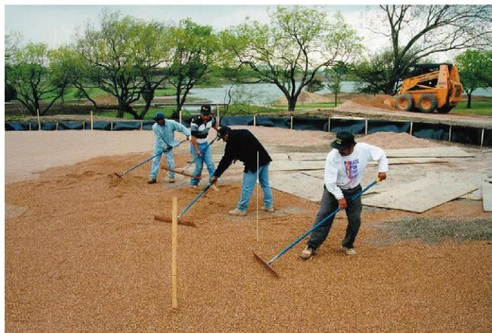
砾石应该填铺至少 4 英寸的厚度—以标杆为准。砾石层的轮廓应该“反映”推杆表面最终应该达到轮廓形状。
