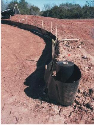
高尔夫球场最常使用的是 18 英寸宽，30 ml 的材料。越厚重就越容易安装，因为比较硬，在安装的时候更容易站立。额外的厚度被认为能提供更长久的保护—防止狗牙根草的根茎从地下入侵翦股颖草或狗牙根杂交品种的果岭。另外，将较厚的屏障伸出 4 英寸—6 英寸到根区混合物表面之上，这样，混合物就会避免收到冲刷和/或来自附近区域的径流污染。这长出来的 4 英寸（屏障），将留在原处，经过草籽或苗种的种植，直到果岭准备好进行首次剪草的时候才除去。届时使用地毯割刀把多余部分切除，稍低于周围的高度。
