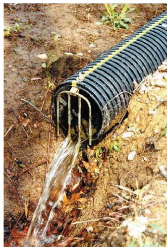
排水管线的终端必须加以保护，以防止动物进入管道。
