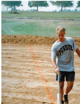
使用喷漆和标记枪使排水管线的布局更加容易。
