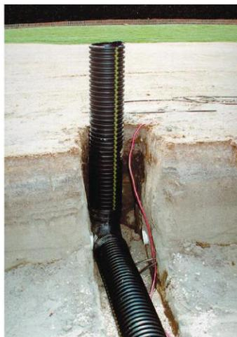
将导线的端部放置在靠近喷头或“冲排口”处，便于寻找。
